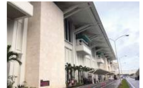
幕下パネル 那覇空港連絡ターミナル（沖縄県那覇市）
